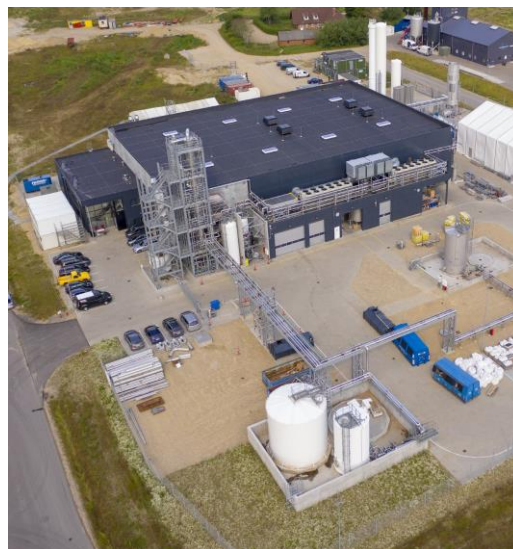
Billede af plastbehandlingsanlægget i Skive Kommune
